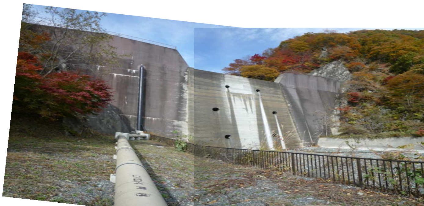
① ダムの袖部より伸びる送水管
